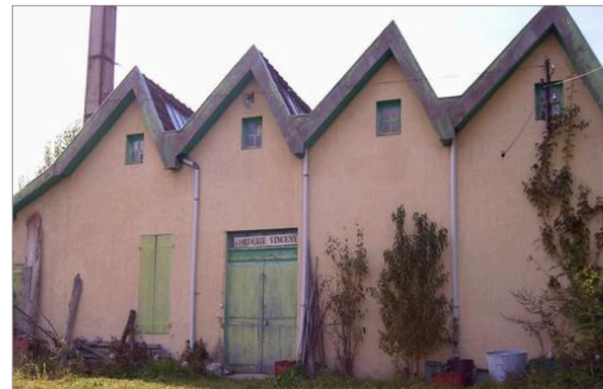
L'ancienne corderie Vincent de La Chapelle-de-la-Tour. Créée en 1914, elle a fermé en 2000.
