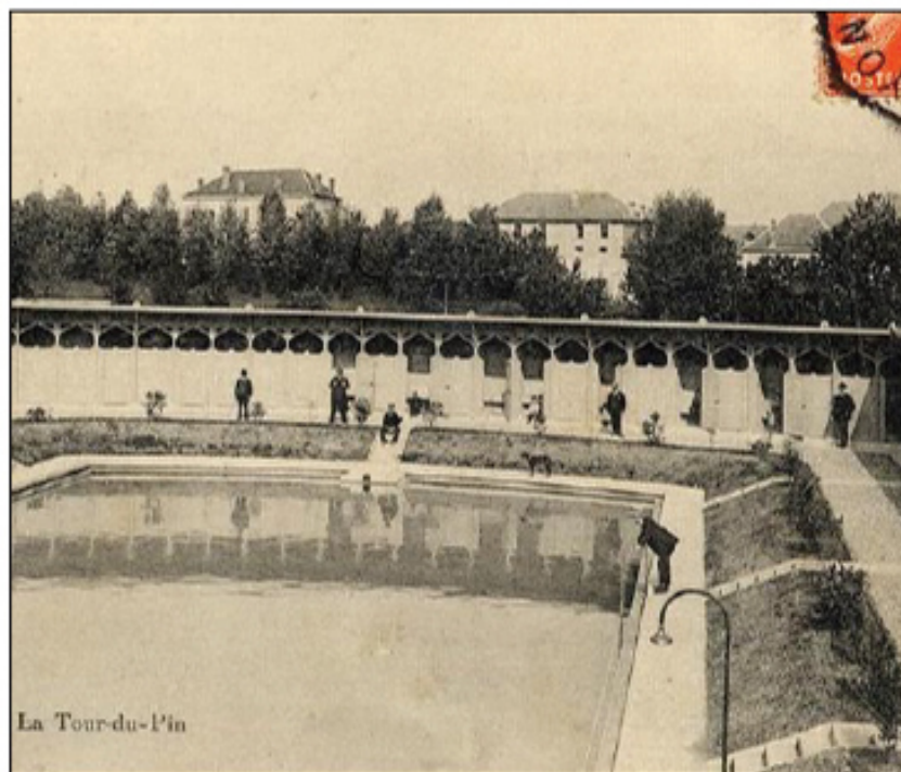
L'antique piscine de 30 X 15 m comporte un grand bain de 1,90 m et un petit bain commençant à 45 cm. Le bassin est entouré de 70 cabines dont quelques-unes ont été préservées et restaurées sous le mandat de Maurice Durand dans le cadre des travaux d'aménagement du clos Bargillat.
